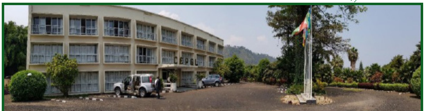
Bureau ABAKIR au bâtiment CEPGL (Communauté Economique des Pays des Grands Lacs) à Rubavu, Rwanda
